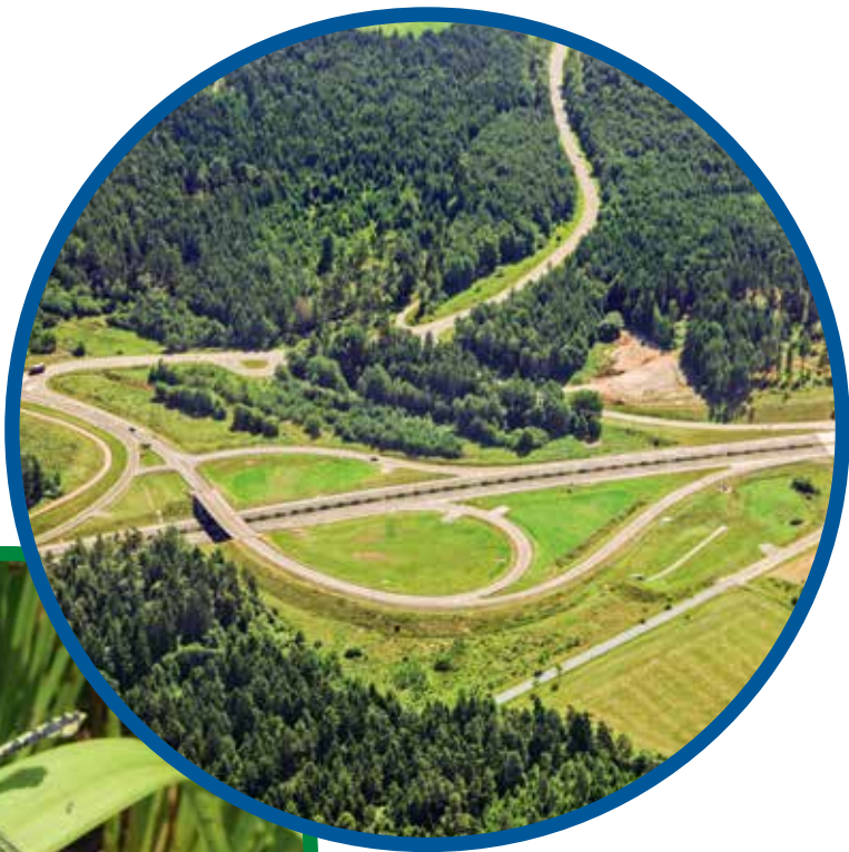
Die Autobahnschleife der A73 bei Eisfeld zerschneidet den Lebensraumverbund Grünes Band. Der Bau einer Grünbrücke würde diesen Effekt abmildern
