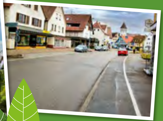
Die Ortsdurchfahrt Rudersberg im Rems-Murr-Kreis vor und nach dem Umbau zu einem »Shared Space«.
